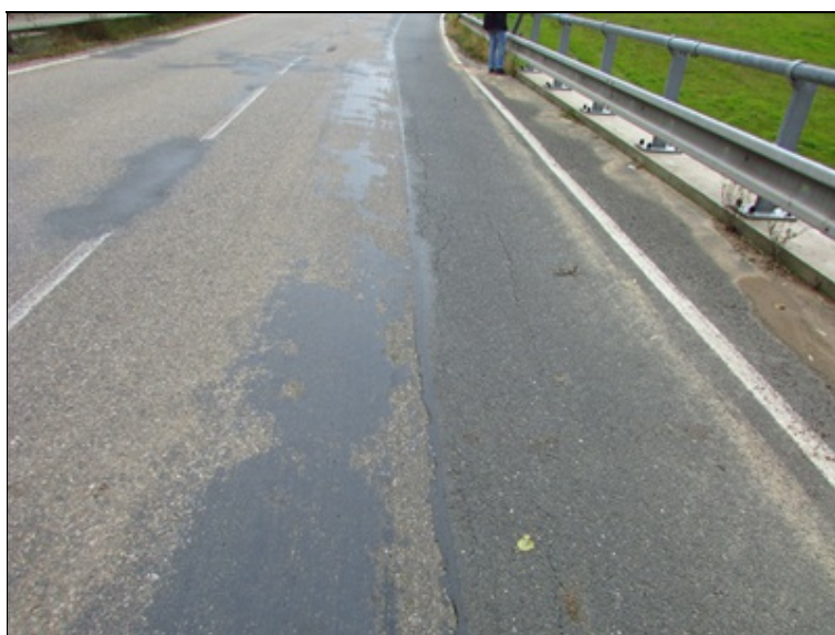
Živičná vozovka vlevo : výspravy, trhliny, nerovnosti
