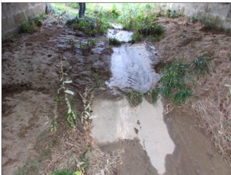
Koryto vodoteče pod mostem : nánosy
