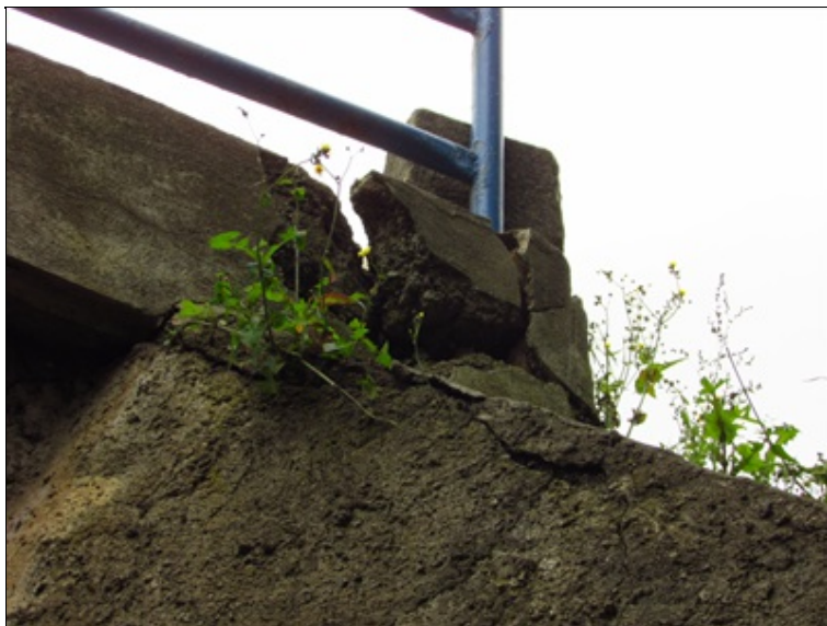
Rozpadlý beton levé římsy
