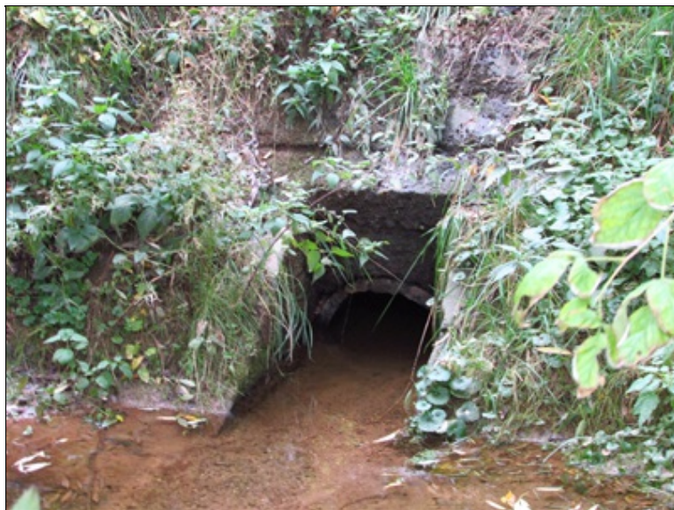
Betonová roura slouží pro převedení normálního průtoku vodoteče.
