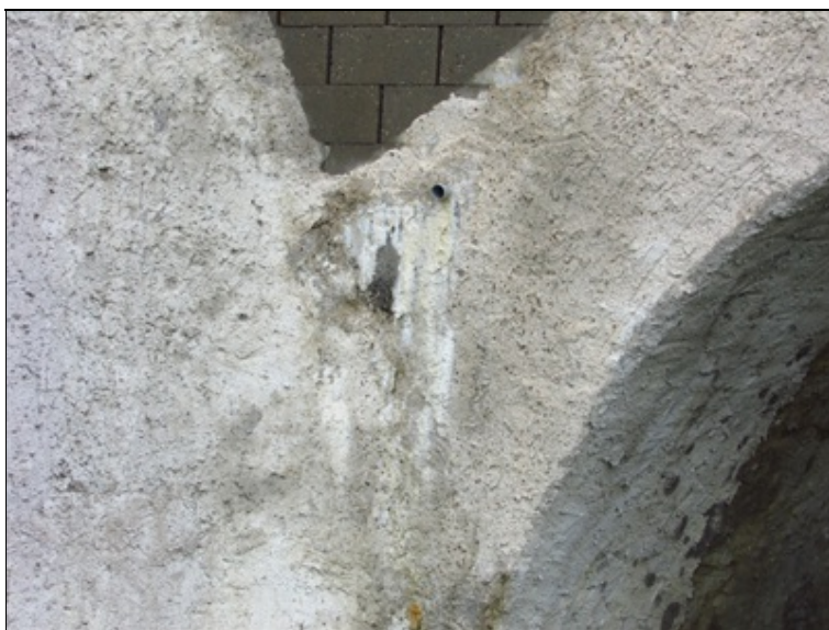
Pravá strana : pod odvodňovací trubičkou rubu klenby jsou výluhy.
